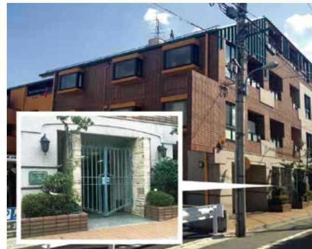
レンガの壁に、緑の屋根のマンション。
